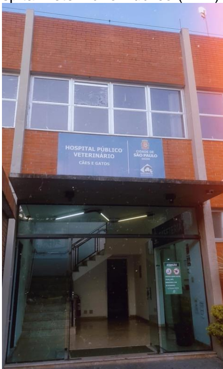
Figura 1 – Fachada do Hospital Veterinário Público (HVP) - zona sul.
