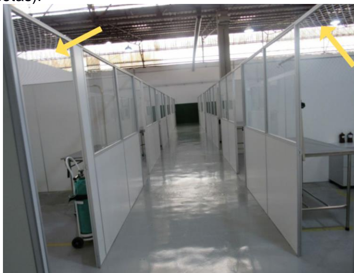
Figura 4 - Corredor dos consultórios do HVP. Os consultórios são delimitados lateralmente por paredes de drywall e a parte superior por rede de proteção (indicado pelas setas).
