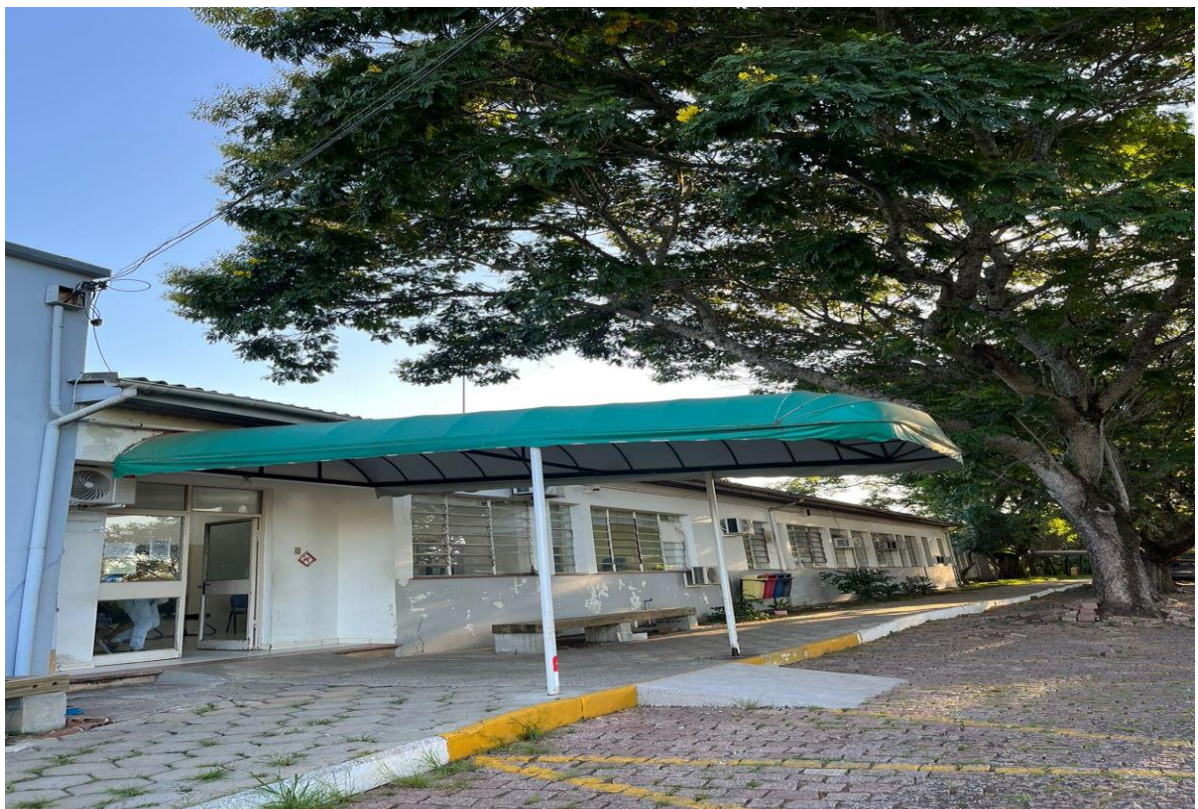
Figura 1 – Fachada do Hospital Veterinário Universitário (HVU).
