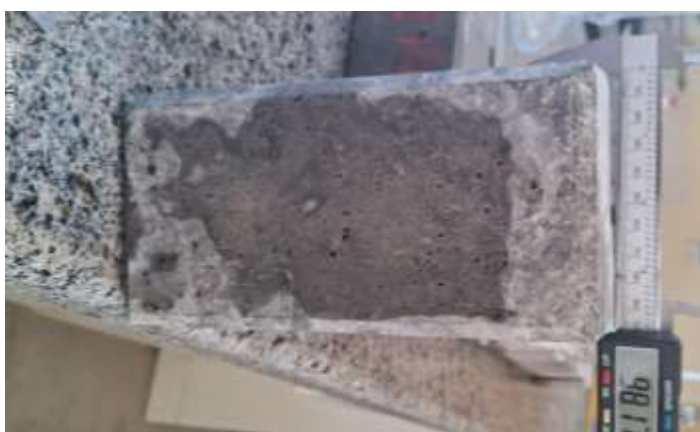
Figura 19- Ensaio Inspeção Visual dos Pavers
