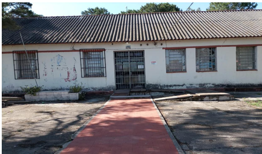
Figura 6 – Prédio da Escola Estadual de Ensino Fundamental Santa Isabel, Santa Isabel, Arroio Grande/RS
