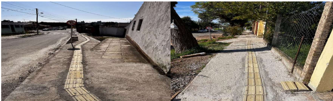
Figura 8 - Fotos de calçadas com piso tátil para a acessibilidade de pessoas com deficiência visual
