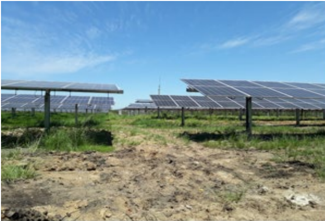
Figura 3 - Usina solar em construção.
