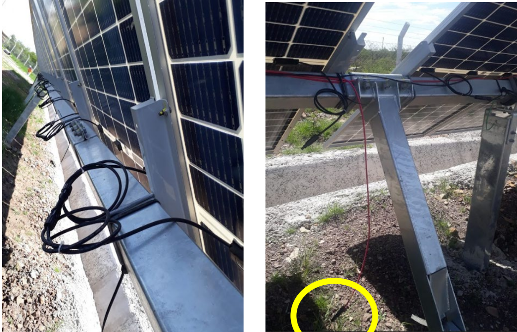
(a) Painéis devidamente instalados
