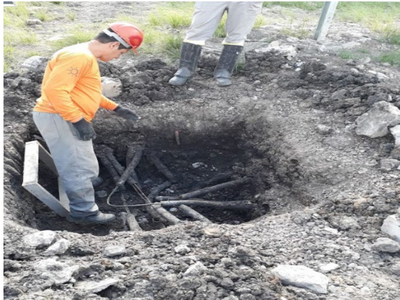
Figura 8 - Correção da caixa de passagem
