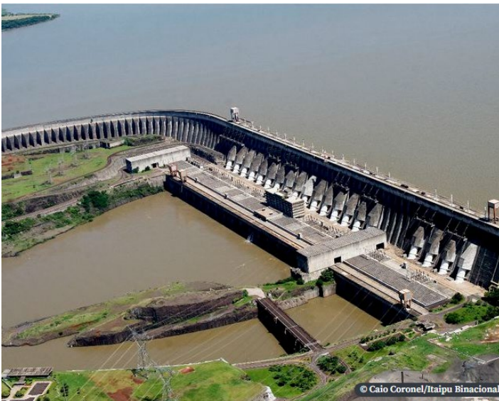
Figura 1- Hidrelétrica de Itaipu
