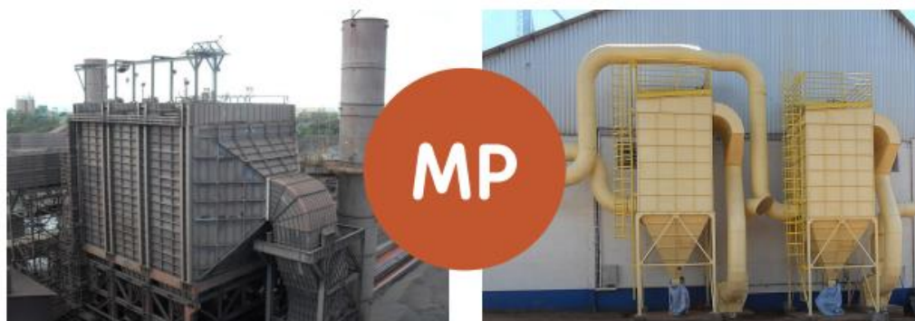
Figura 9 - Precipitador Eletrostático e Filtro de Manga
