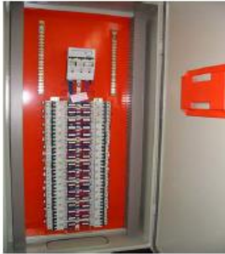
Figura 19 - Vista interna de um painel do tipo caixa
