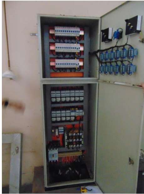
Figura 31 – Vista interna do painel (não compartimentado)
