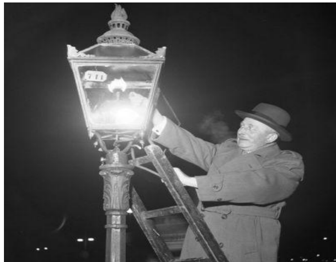
Figura 6– Operário acionando o sistema de iluminação pública a gás.
