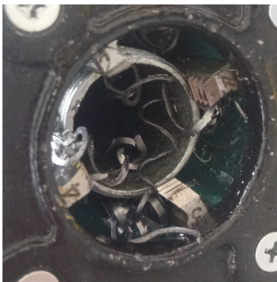
Figura 5 – Execução de rosca NPT na tubulação metálica
