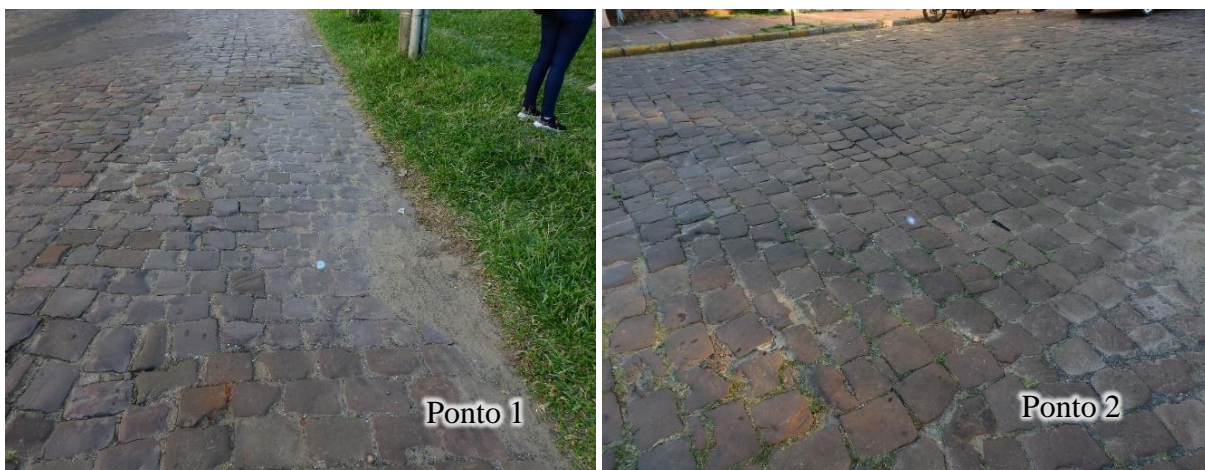
Figura 22 - Demarcação dos pontos no ensaio
