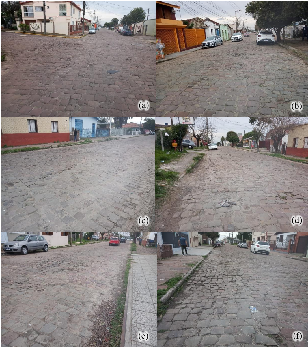
Figura 17 – Situação da via antes da restauração asfáltica
