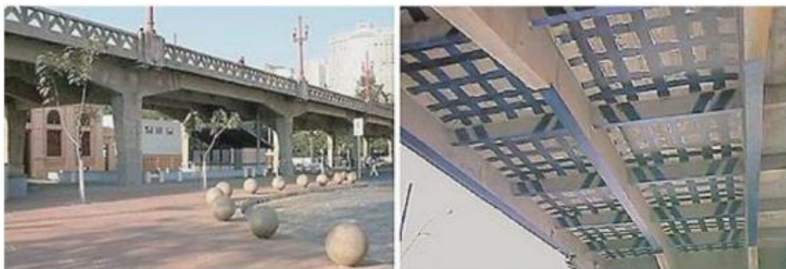
Figura 1 - Reforço no viaduto em Minas Gerais utilizando FRP
