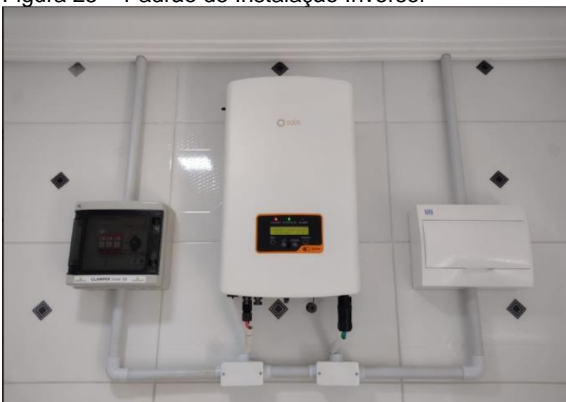
Figura 25 – Padrão de Instalação Inversor
