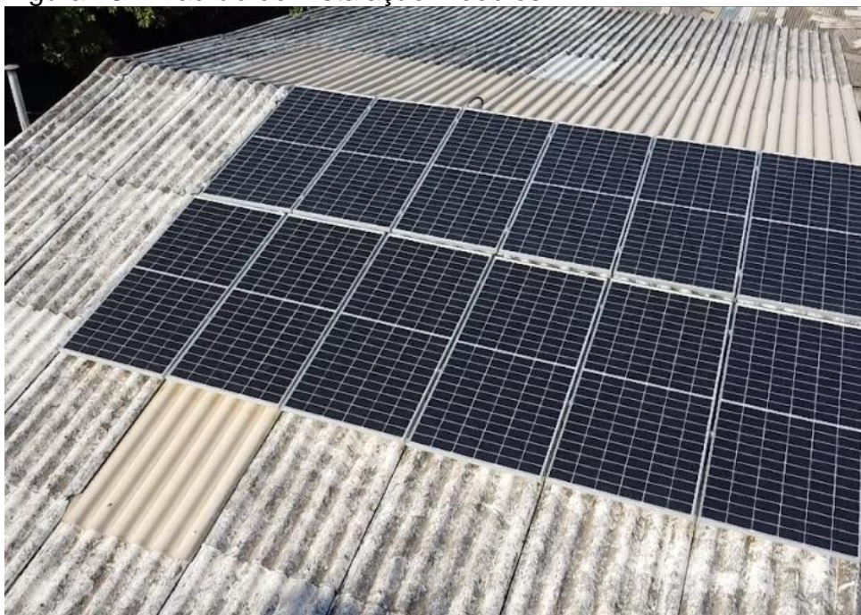
Figura 26 – Padrão de Instalação Módulos
