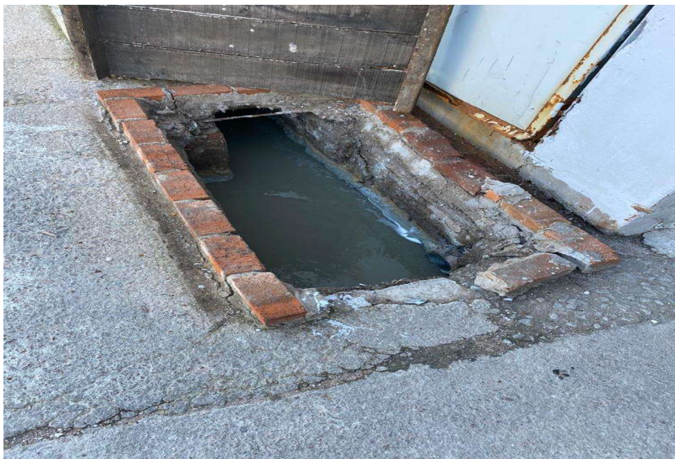
Figura 5- Efluente da etapa do Caleiro na empresa.
