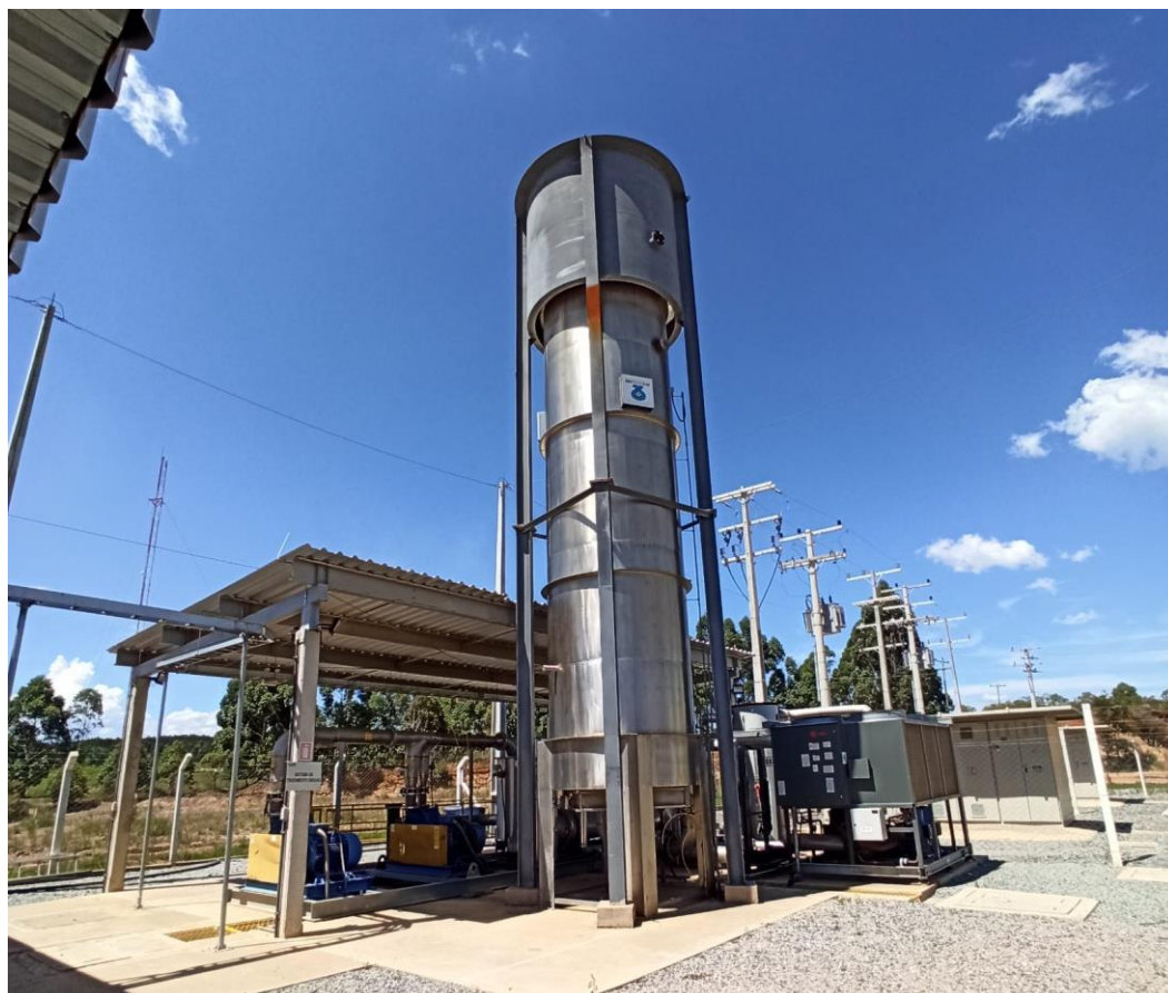
Figura 9 - Planta de Aproveitamento do Metano
