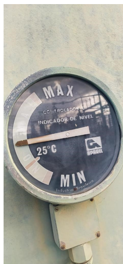
Figura 2.10 – Indicador do nível de óleo TR SE PAL4.
