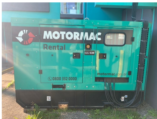
Figura 2.15 – GMG tipo cabinados (ou insonorizados) área externa SE PAL4.
