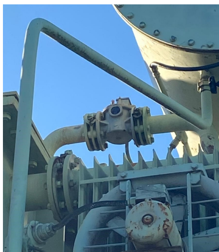
Figura 2.11 – Relé de gás TR SE PAL4.
