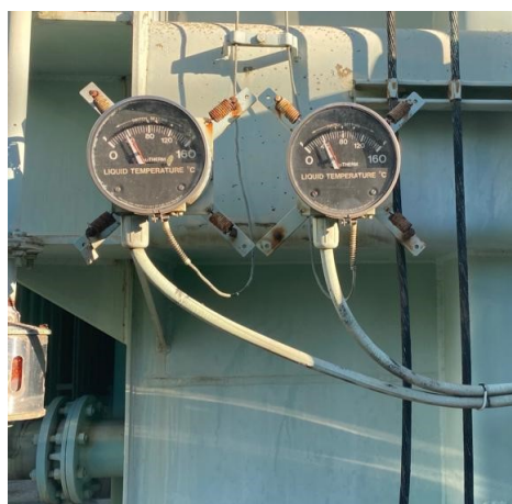
Figura 2.9 – Termômetro do óleo TR SE PAL4.
