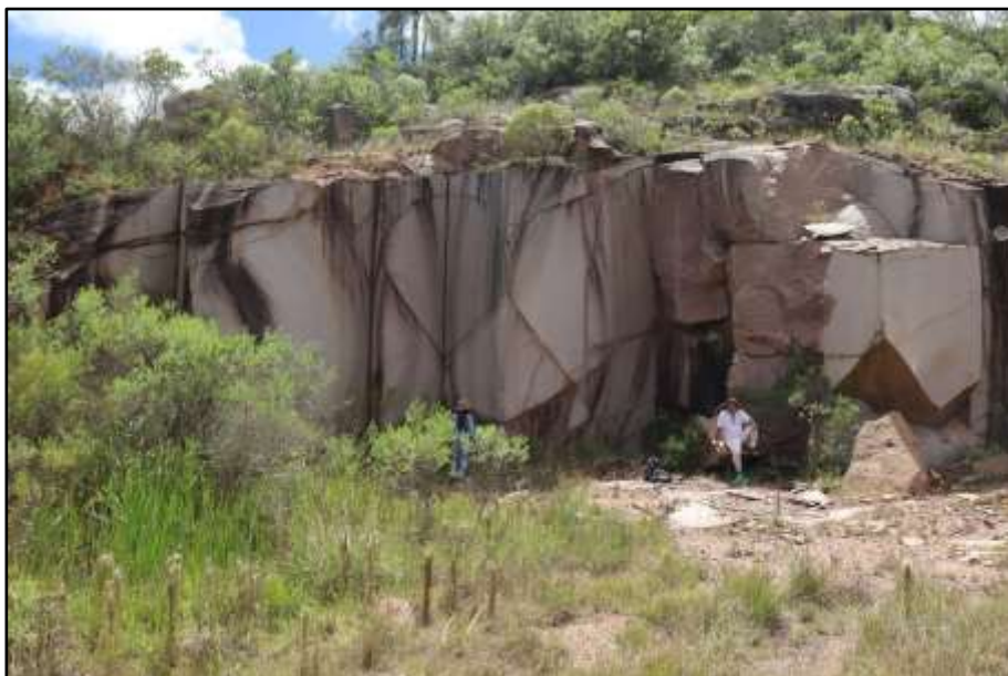
FIGURA 6 - Frente de lavra abandonada do Granito Jaguari.
