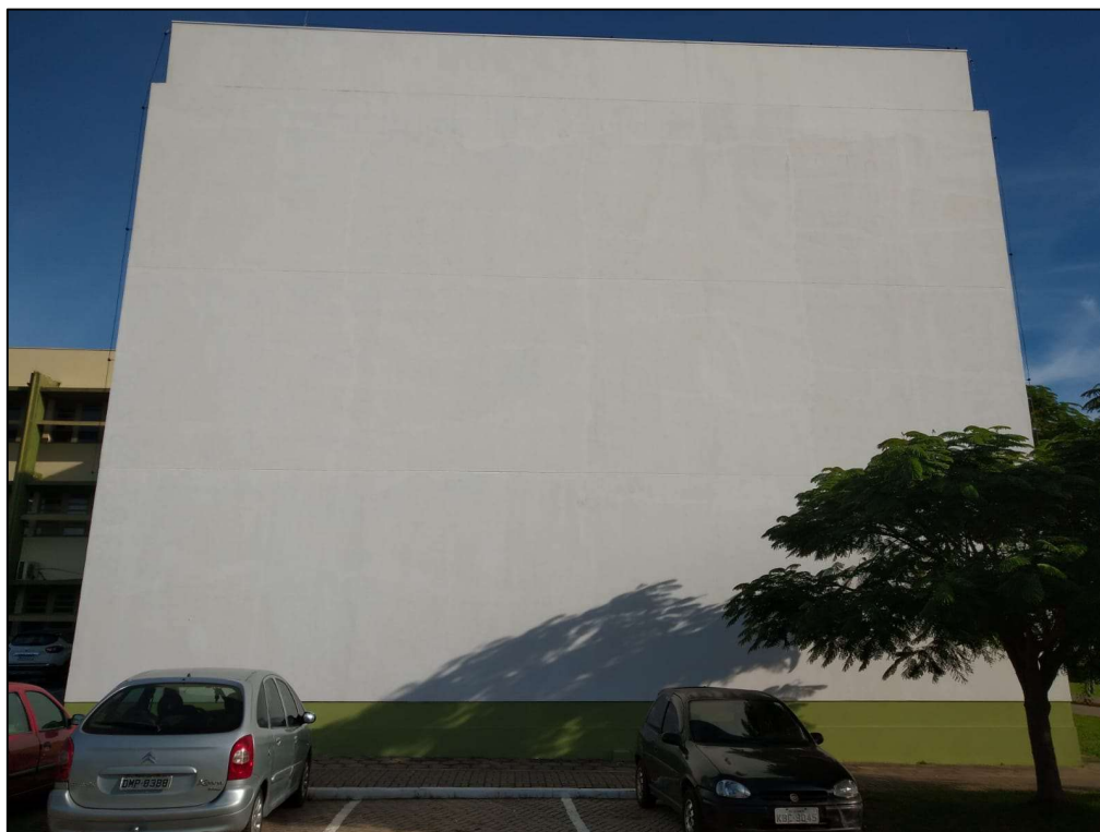
Figura 22 – Fachada do prédio administrativo da UNIPAMPA Campus Alegrete
