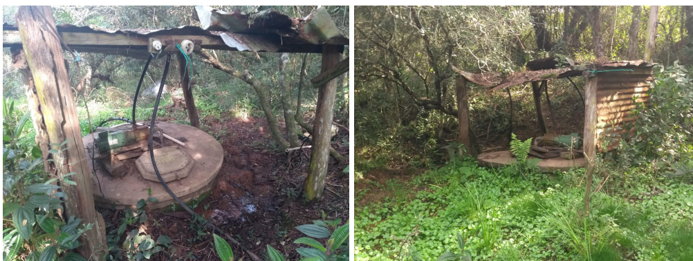
Figura 11- Imagem do poço raso no ponto 4.
