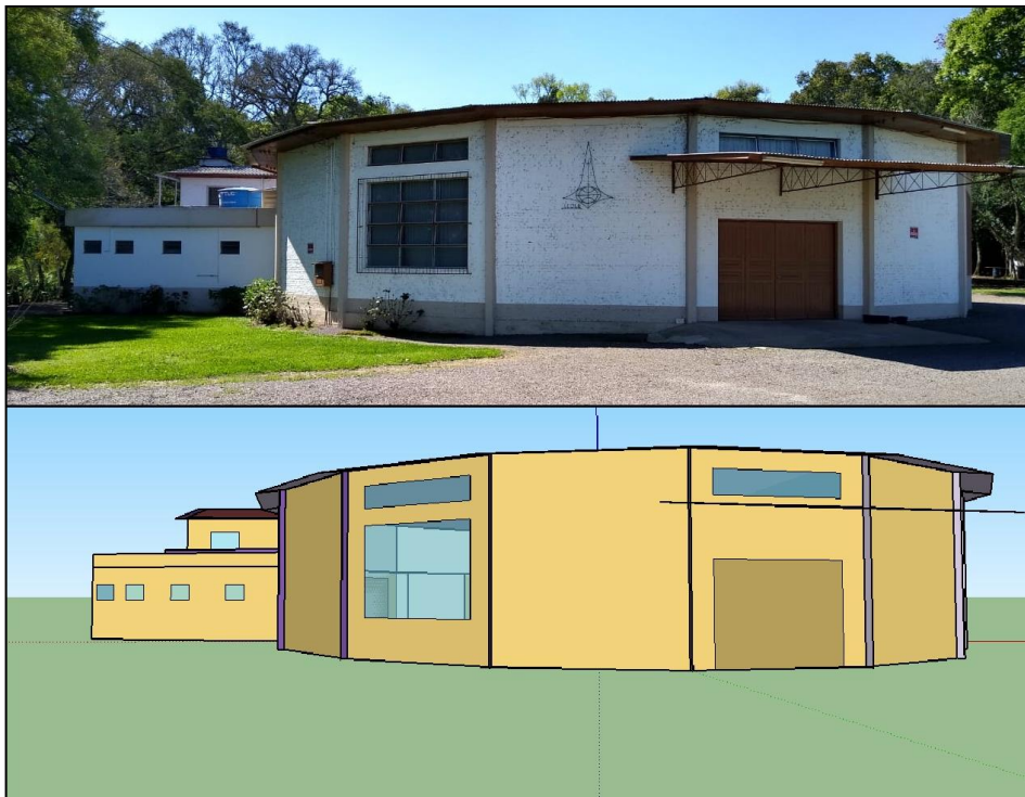
Figura 12 – Comparação modelo X edificação – Fachada frontal esquerda.
