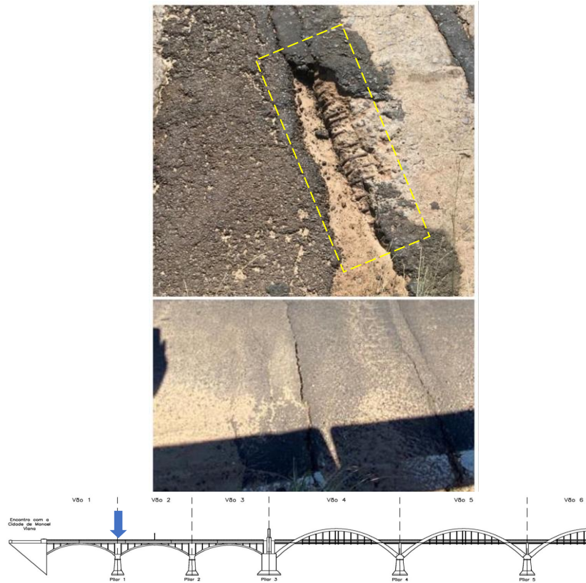
Figura 32 – Junta de dilatação do Pavimento sobre o Pilar 1 antes e depois da revitalização.
