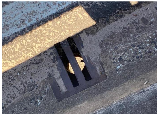
Figura 33 – Tubo de escoamento pluvial.
