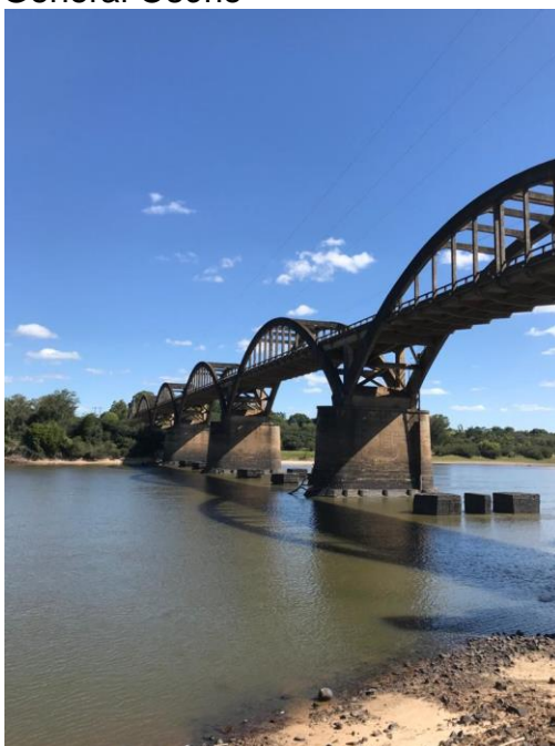
Figura 20 - Ponte General Osório
