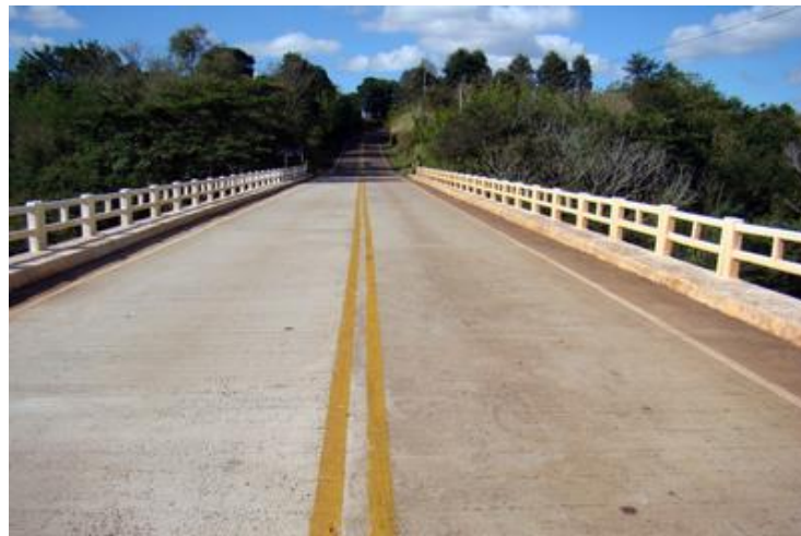
Figura 18 – Pavimento sobre ponte.
