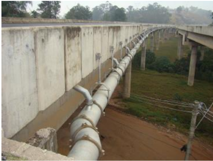
Figura 17– Sistema de Drenagem.
