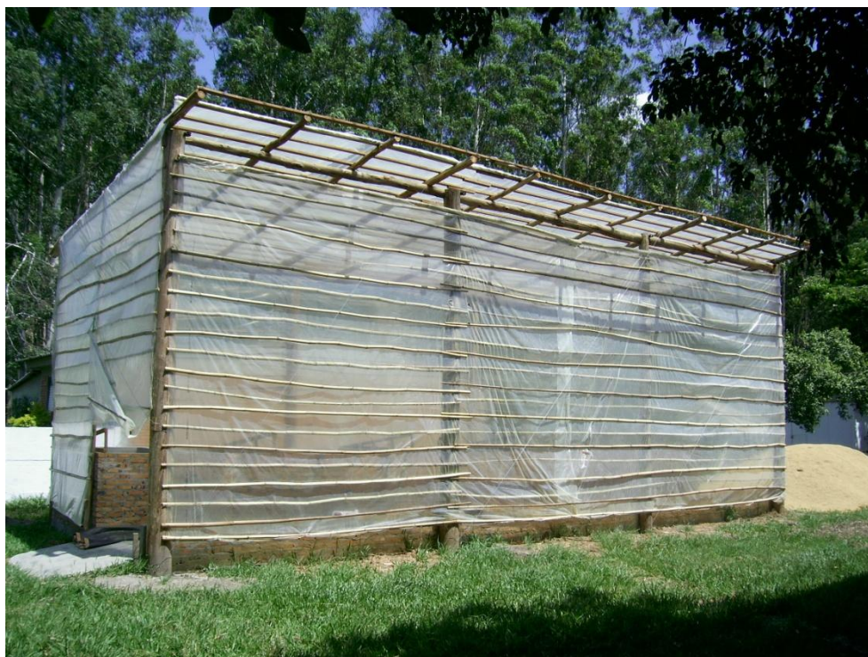
Figura 2 - Estrutura experimental concluída.
