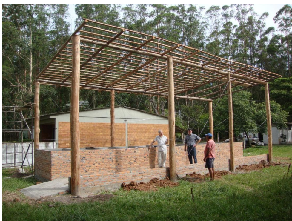
Figura 1 - Composteira sendo construída.
