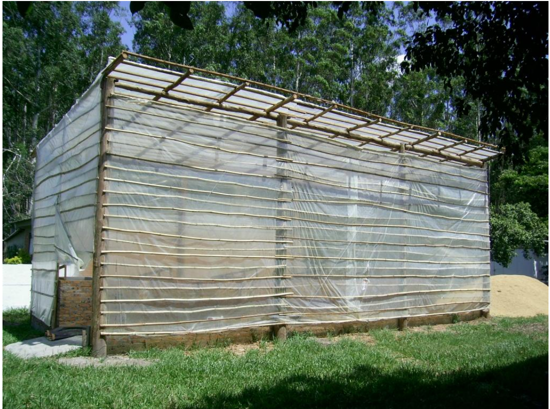
Figura 2 – Estrutura experimental concluída.
