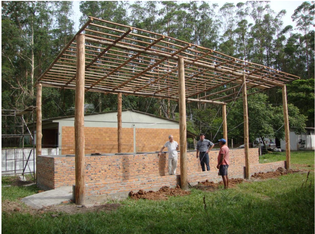
Figura 1 – Composteiras em fase final de construção.
