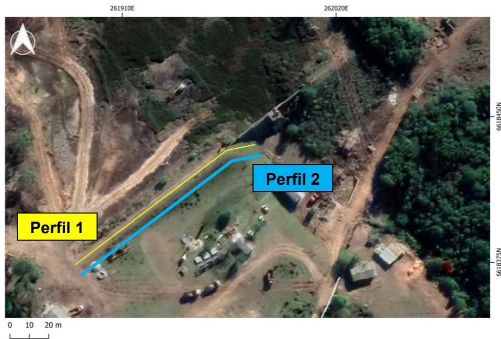
Figura 28. Localização dos perfis de levantamento geofísico da barragem.
