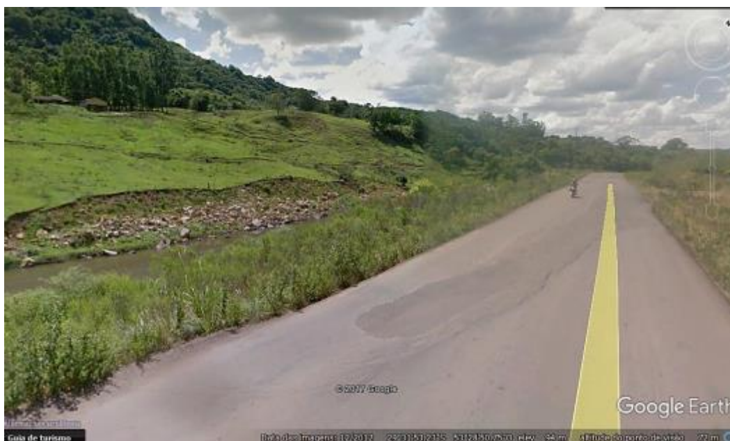
Figura 13- Situação na rodovia em 2012, antes do deslizamento.
