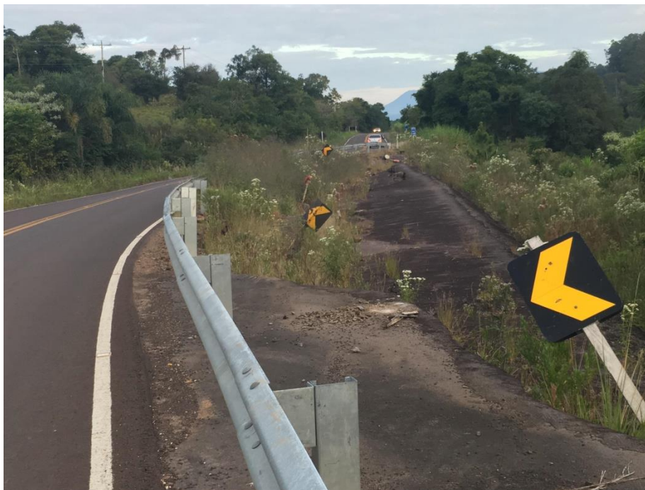
Figura 17-Foto da rodovia em 2019.
