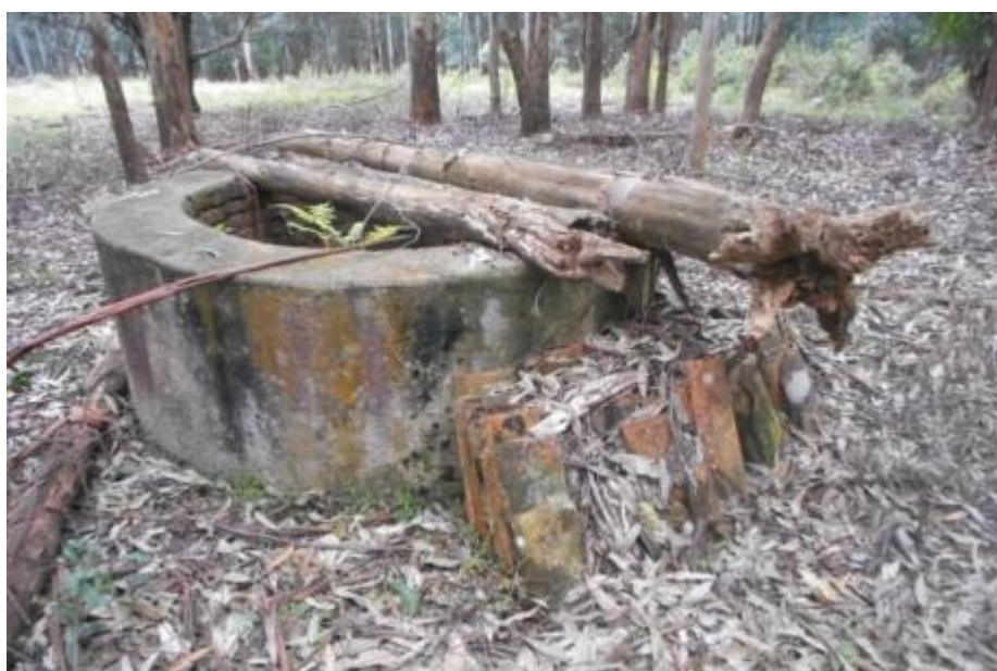
Figura 6 - Poço em meio à silvicultura com empilhamento de telhas
