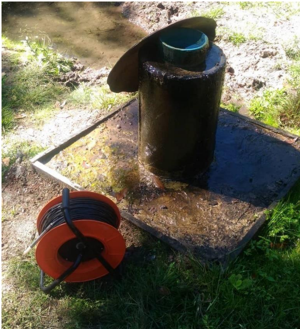
Figura 18: Poço tubular construído para o abastecimento
