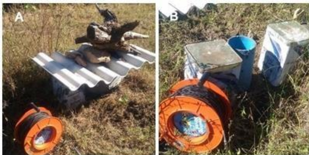
Figura 16: Poço Tubular 2: A) Fechado de forma precária; B) Situação.
