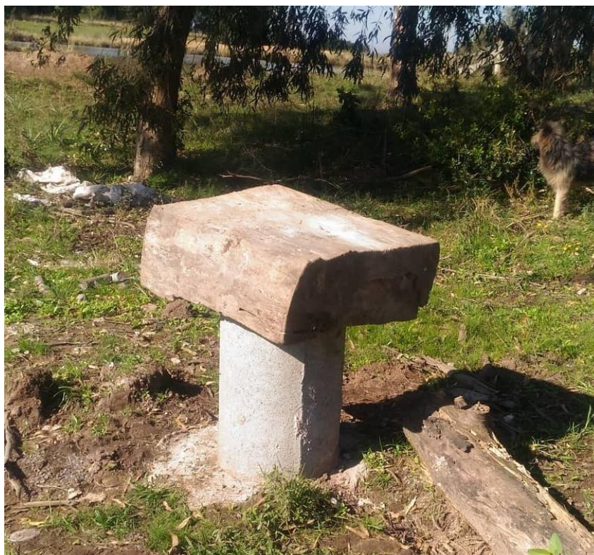
Figura 19: Poço tubular em fase final de construção
