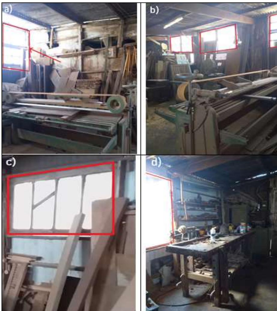
Figura 13 – Aberturas da marcenaria: a) janela fixa e telhado de zinco; b) janelas fixas; c) abertura do tipo maxim-ar e d) abertura do tipo veneziana
