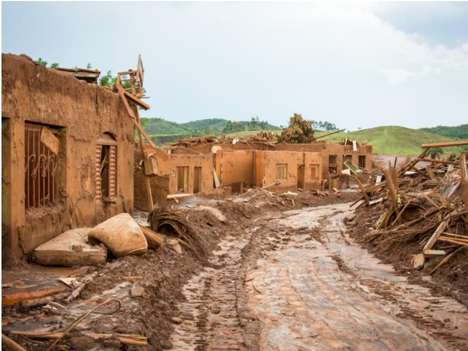
Figura 12- Devastação em distrito após rompimento de barragem de rejeitos
