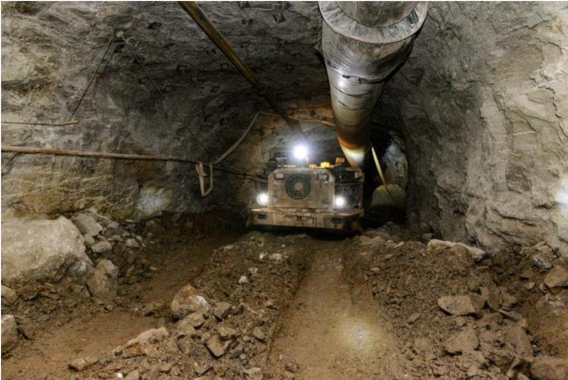
Figura 5- Local de lavra subterrânea
