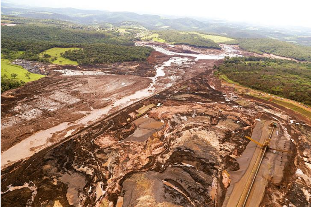
Figura 11- Localidade coberta por lama após rompimento de barragem de rejeitos.
