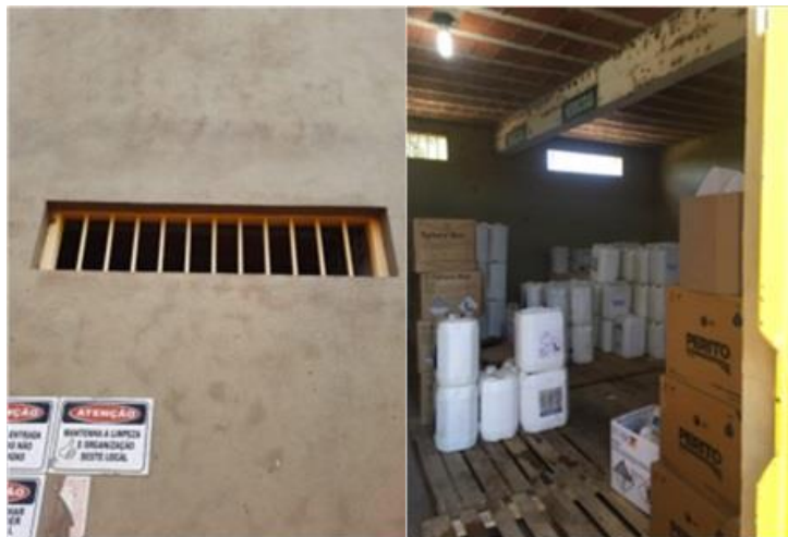
Figura 6 – Abertura para aeração do depósito de armazenamento de agrotóxicos.
