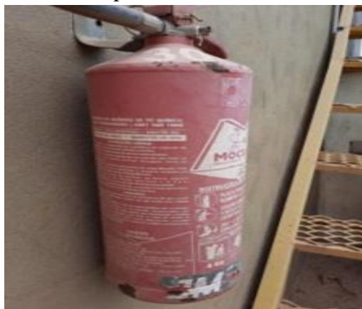
Figura 24 – Extintor de incêndio disponível na área externa do local de armazenamento.
