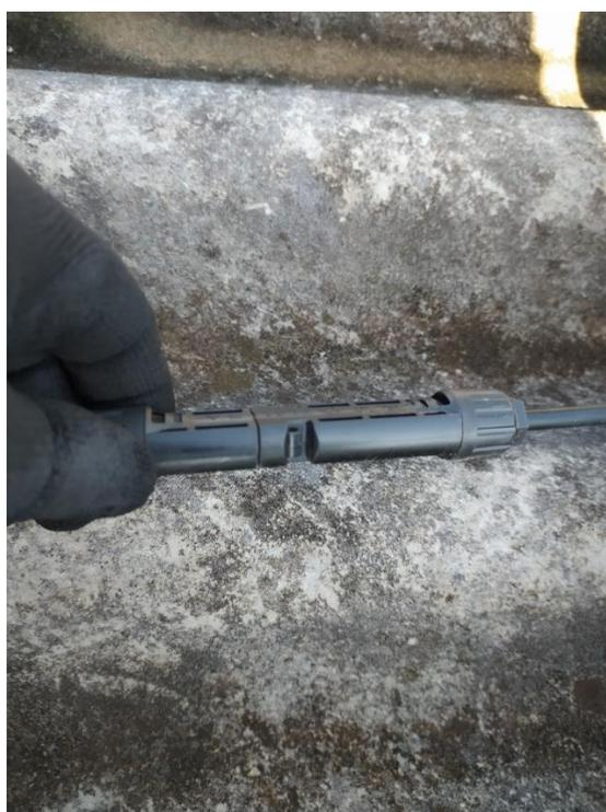
*Figura 16 – Conector MC4 protegido sob os módulos*
