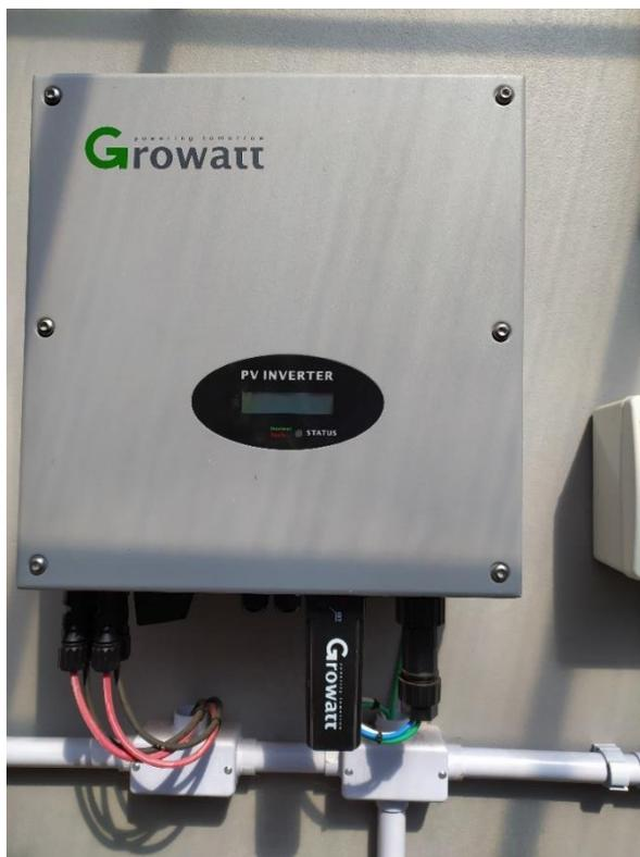
Figura 19 – Conectores MC4 acoplados ao inversor
