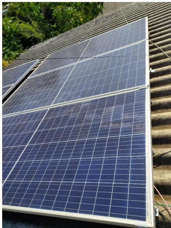
O cabeamento que está posicionado sobre o telhado não apresentou avarias conforme ilustrado na Figura 14.
