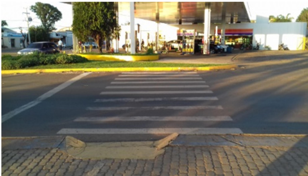
Figura 34: Rampa e faixa de segurança no Parque Esportivo General Vargas Fonte: acervo do autor (2018)
