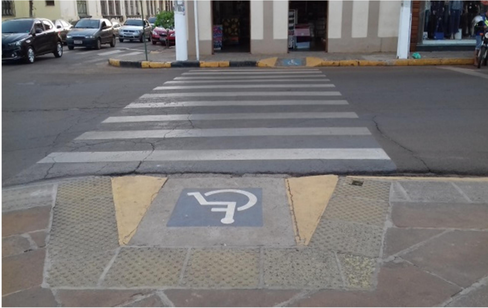
Figura 31: Rampa, pisos táteis e faixas de segurança na Praça XV de Novembro Fonte: acervo do autor (2018)
