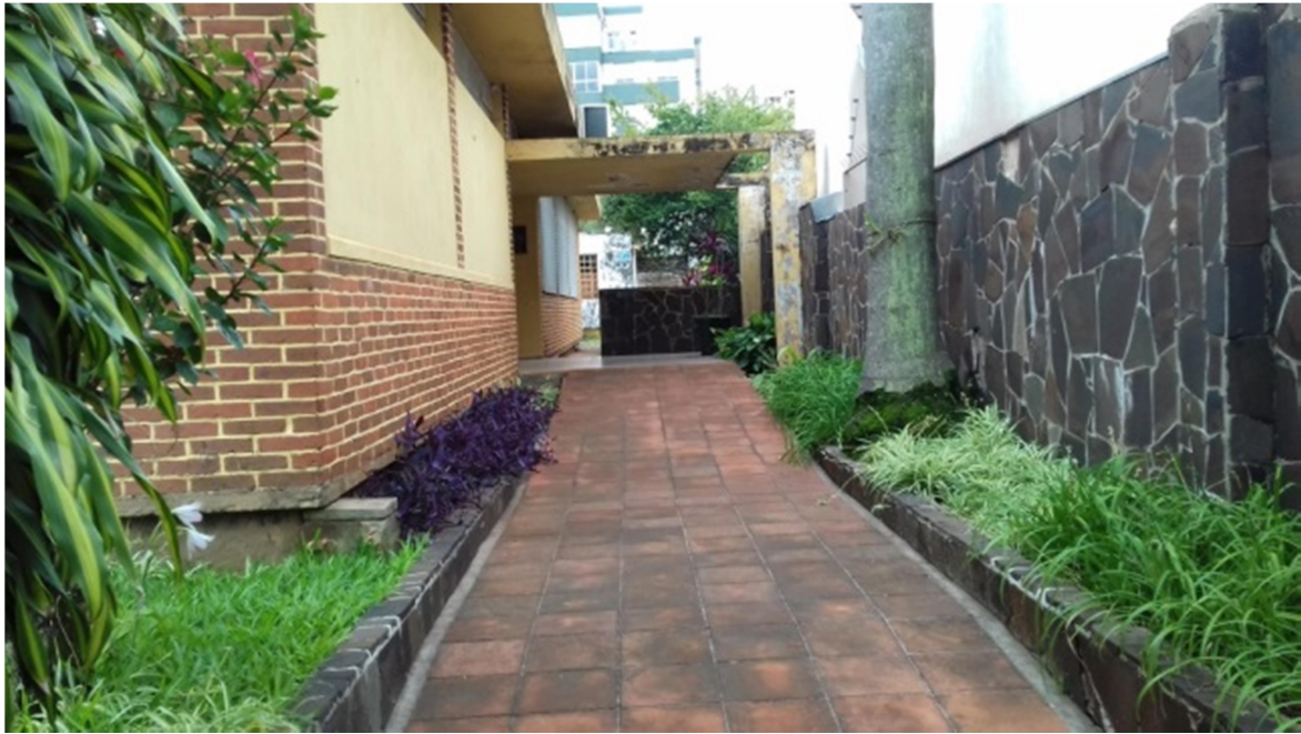
Figura 39: Rampa de acesso ao Museu Municipal Apparício Silva Rillo Fonte: acervo do autor (2018)
