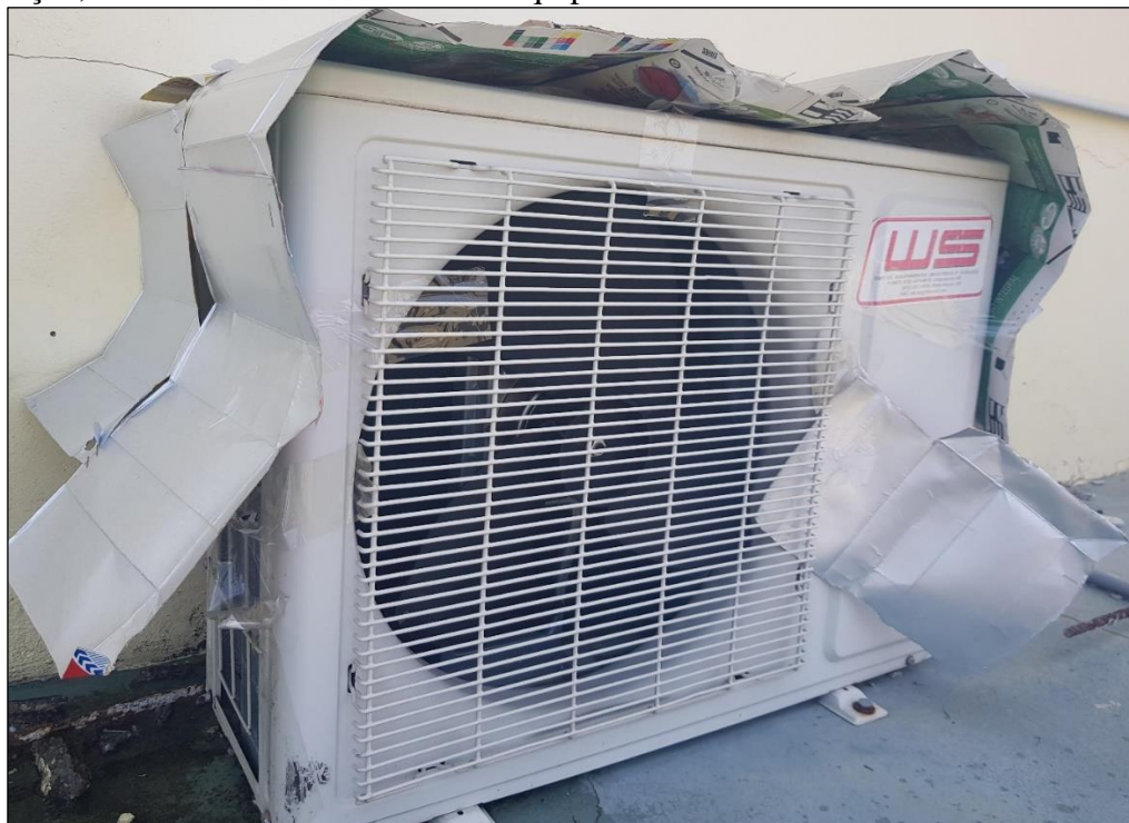
Figura 35 – Vista externa do painel formado pela disposição das caixas Tetra Pak após higienização, na unidade condensadora do equipamento.
