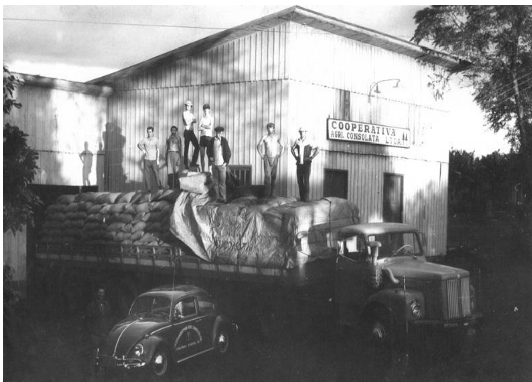
FIGURA 1 -Primeiro armazém para recebimento de grãos. Fonte: Copacol.
