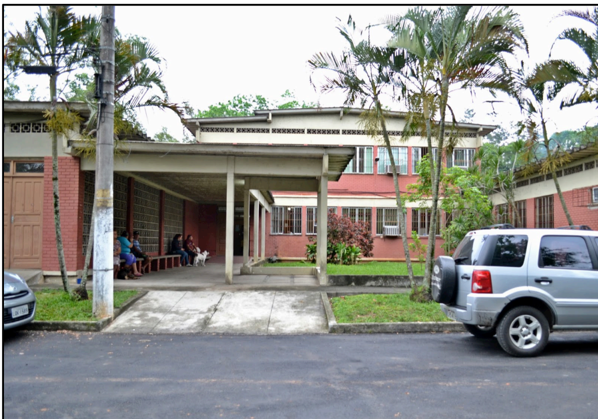
FIGURA 1 Fotografia da fachada do Hospital Veterinário de Pequenos Animais da Universidade Federal Rural do Rio de Janeiro, Seropédica-RJ. Fonte: Arquivo pessoal.
