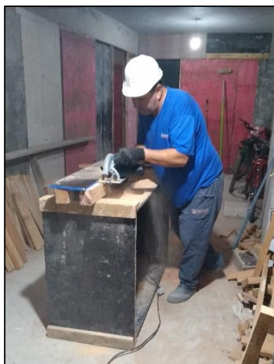
Figura 14 – Execução corpos de prova
