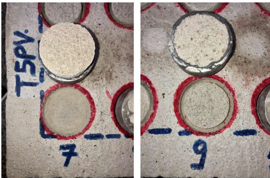
(a) Ruptura A/S: na interface argamassa-substrato.
