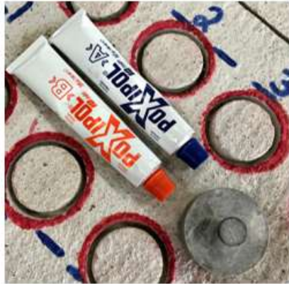
1. Preparação do material e limpeza das superfícies.
