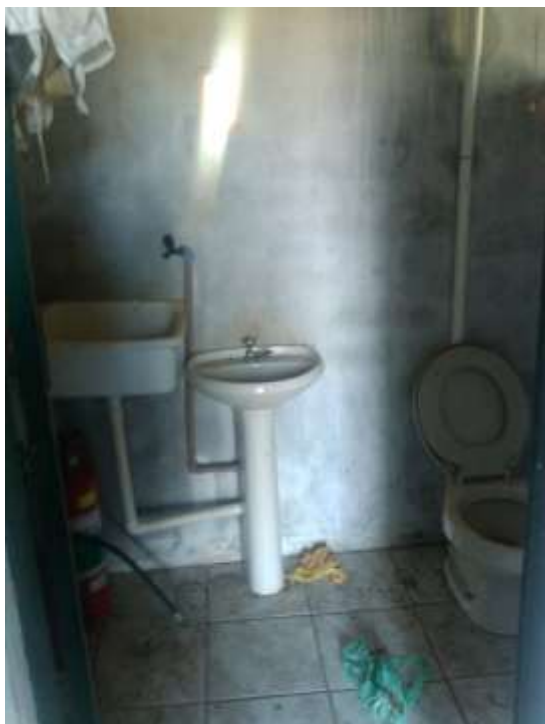
Figura 8 – Banheiro / vestiário do posto Fonte: Autora, 2017.
