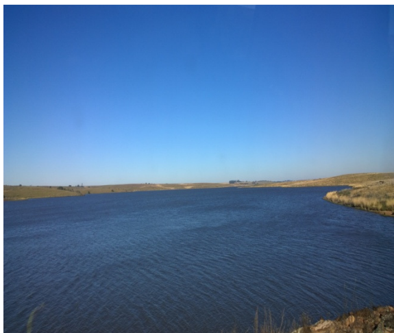
Figura 11 - Área do reservatório, à jusante da bacia hidráulica VAC4.
