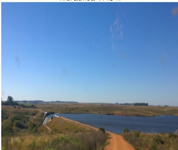
Figura 10 - Ponto 02, à jusante da bacia hidráulica VAC4, barragem.
