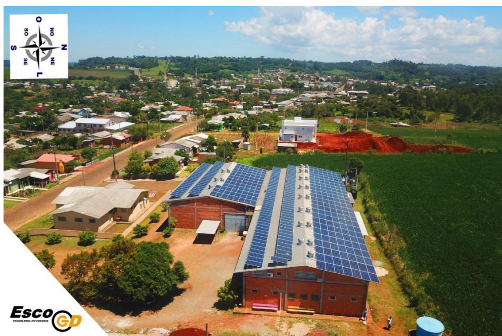
Figura 20 - SFCR instalado no telhado com 126,4 kWp de potência total
