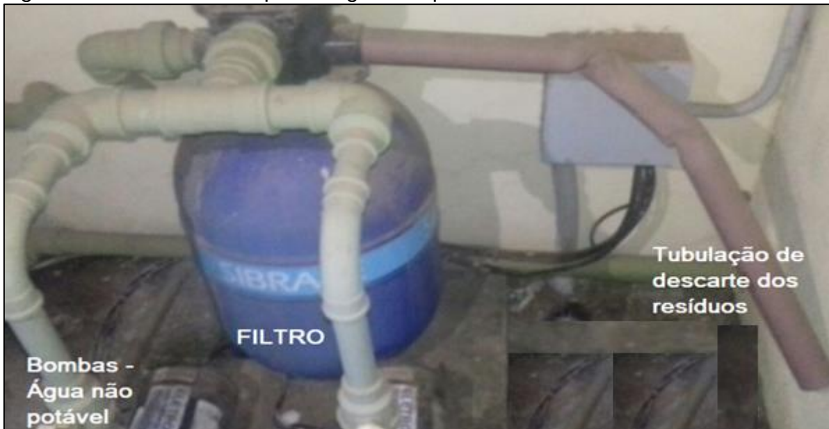
Figura 10 – Filtro utilizado para a água não potável
