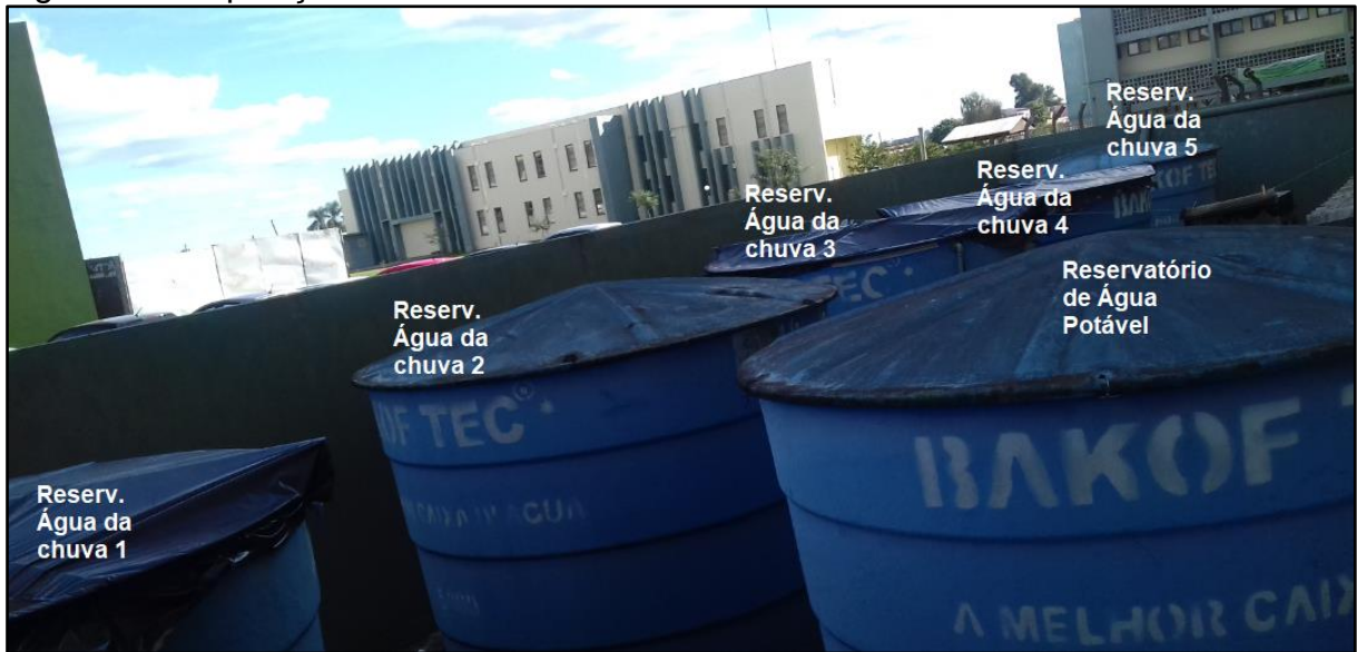
Figura 7 – Disposição dos reservatórios inferiores
