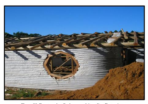
Figura 08: Estrutura do telhado em madeira roliça. Fonte: Autor.
