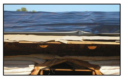
Figura 05: Instalação da geomembrana. Fonte: Autor.
