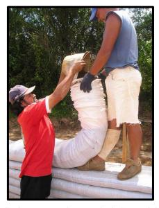
Figura 02: Trabalhadores erguendo a parede de Superadobe. Fonte: Autor.
