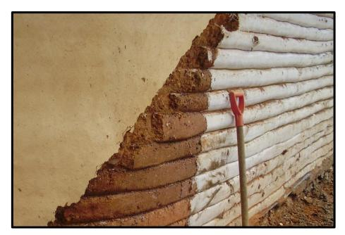
Figura 12: Etapas do revestimento das paredes. Fonte: Autor.
