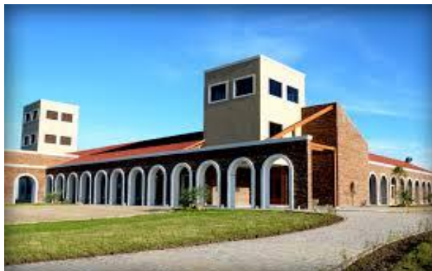
Figura 14 - Prédio da vinícola Guatambu
