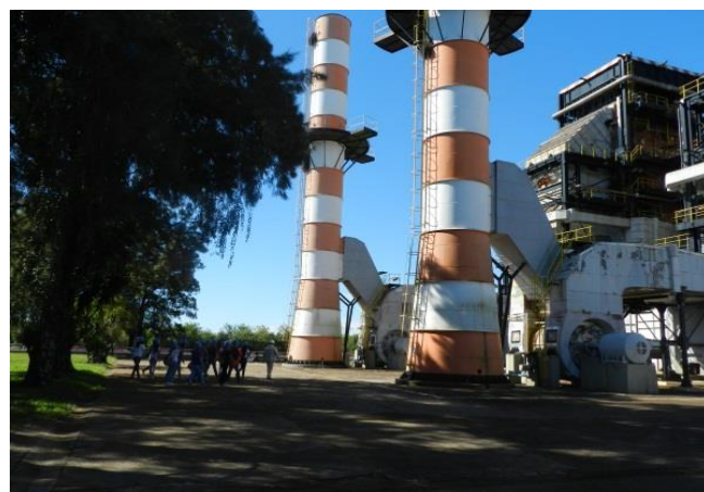
Figura 29 - Visita a Termoelétrica Osvaldo Aranha - Final da visita
