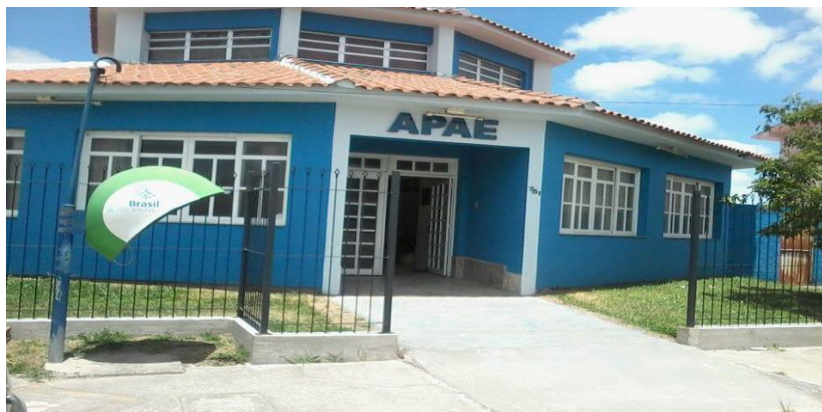
Figura 4 - Vista parcial da fachada da sede da APAE de Arroio Grande/RS
