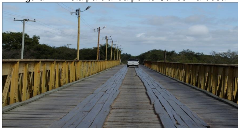
Figura 7 - Vista parcial da ponte Carlos Barbosa
