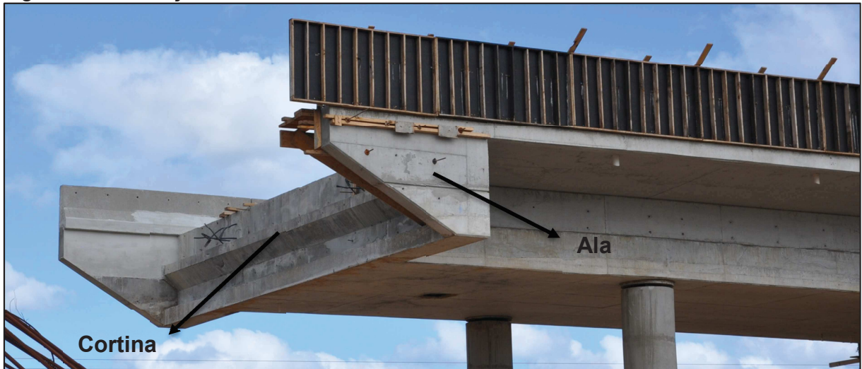
Figura 6 – Ilustração do elemento estrutural ala e cortina
