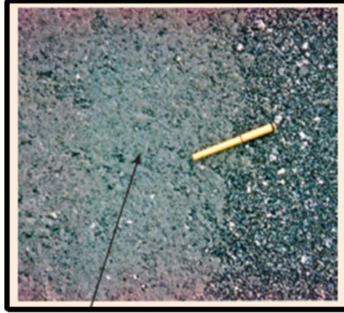
Figura 11 - Brita graduada tratada com cimento
