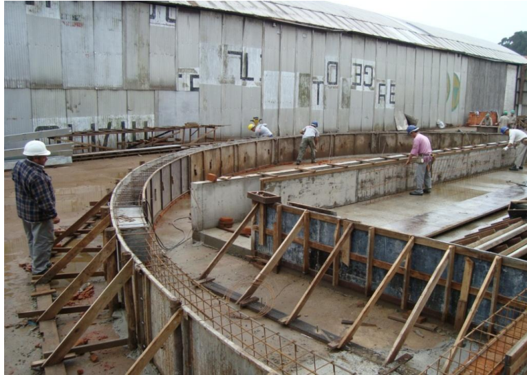
Figura 2.11 - Base de silo em concreto armado Viga x Laje.
