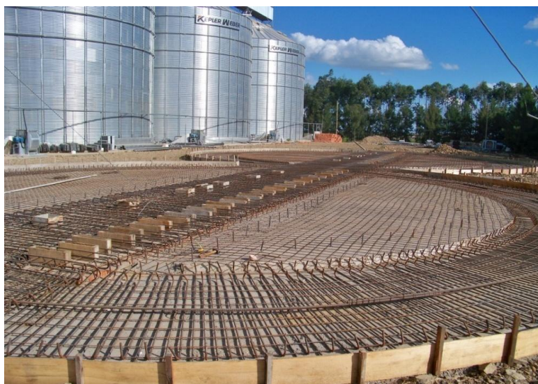
Figura 2.10 - Bases executadas no sistema radier circular.
