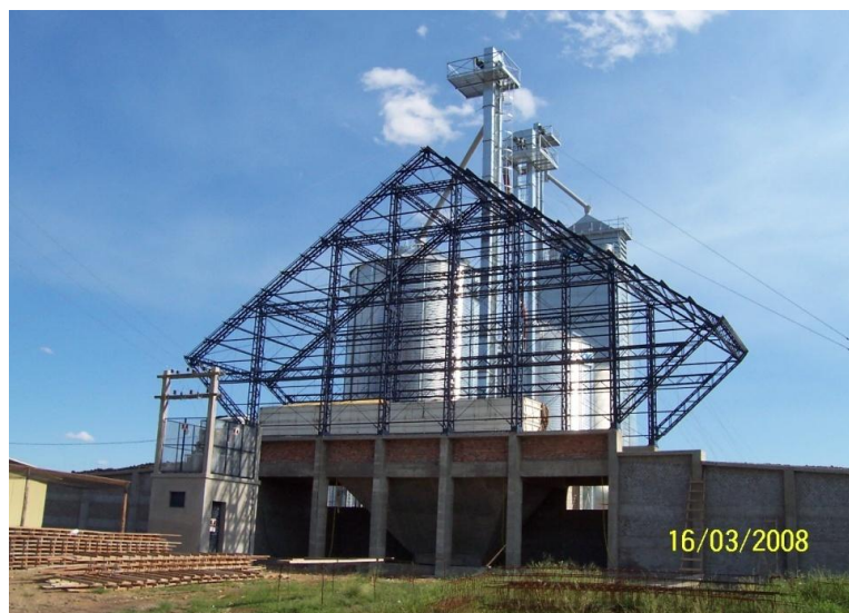
Figura 2.03 - Moega para recebimento de grãos ainda descoberta.
