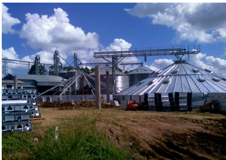
Figura 2.08 - Montagem da estrutura metálica.
