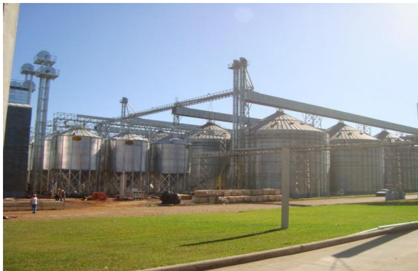
Figura 1.02 – Silos de uma unidade de recebimento de grãos.
