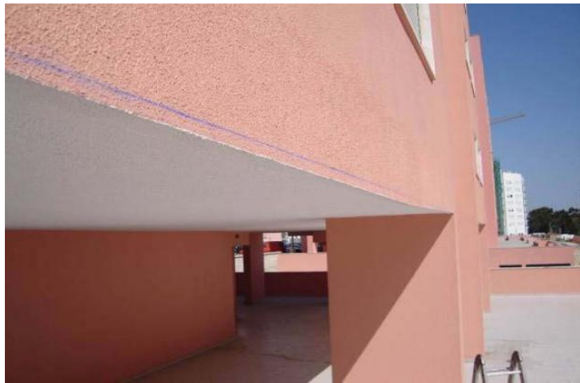
Figura 3.09 – Exemplo de deformação na laje de um piso.
