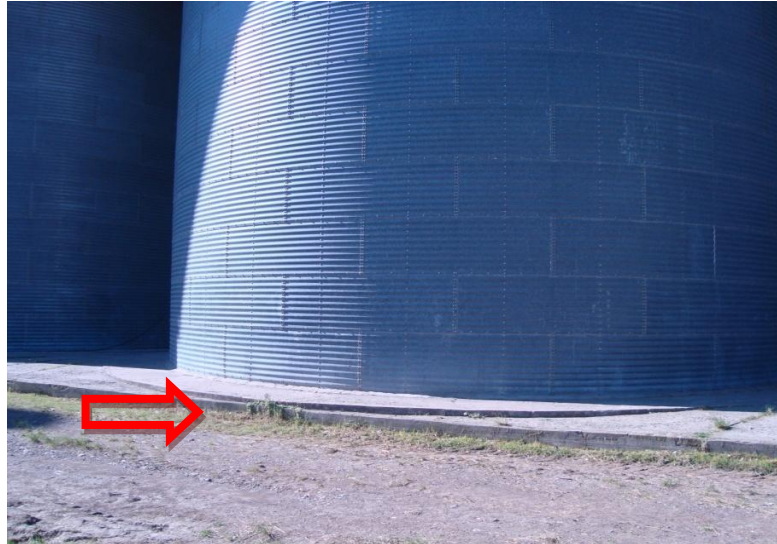
Figura 5.02 – Laje da base do silo exposta ao sol.
