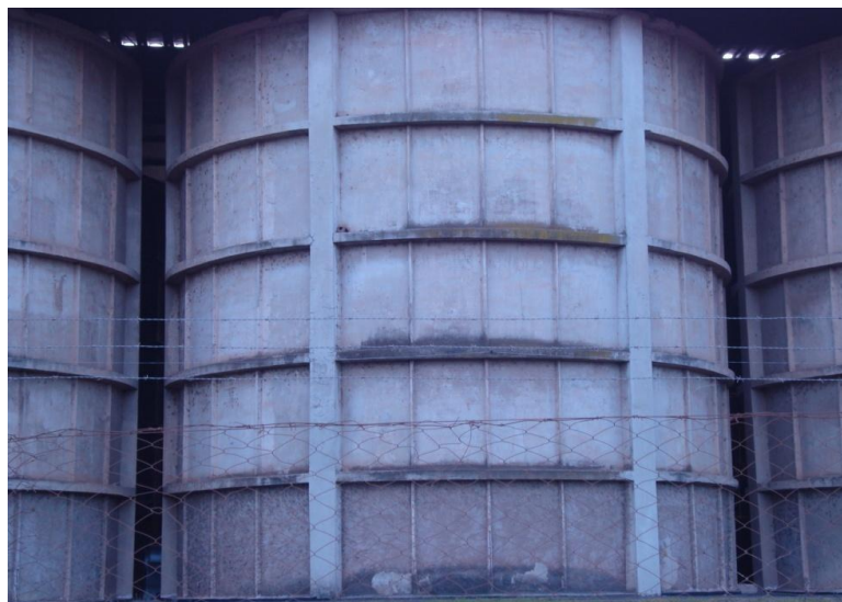
Figura 2.07 - Silo de concreto armado.
