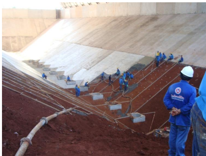
Figura 2.09 - Execução de graneleiro, com fundo V, para estocagem de soja.
