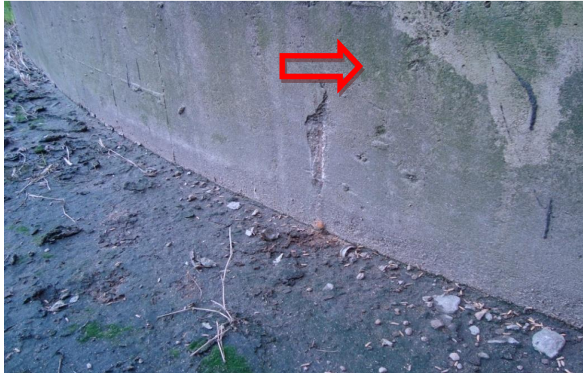
Figura 5.09 - Microorganismos agindo em conjunto com a poeira e umidade do local.
