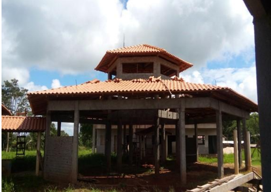
Figura 05 - Obra em andamento - Projeto Espaço Educativo Rural
