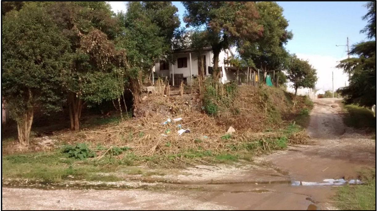
Figura 11- Residências na margem da encosta.
